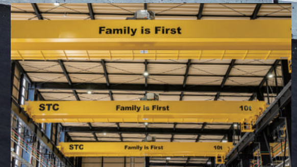
工場棟の「Family is First」の文字が入ったクレーン
