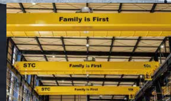
工場棟の「Family is First」の文字が入ったクレーン
