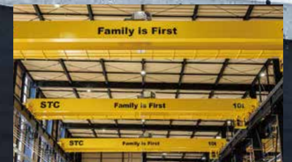
工場棟の「Family is First」の文字が入ったクレーン
